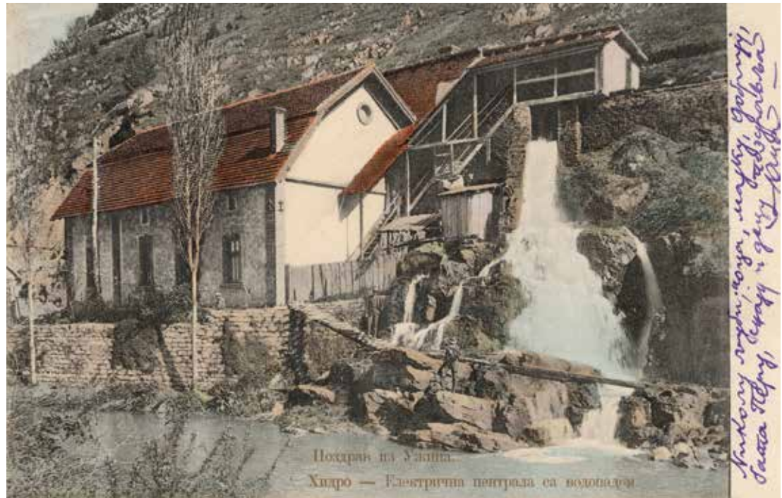
Сл. 79. Електрична централна на реци Ђејињи (разгледница)
