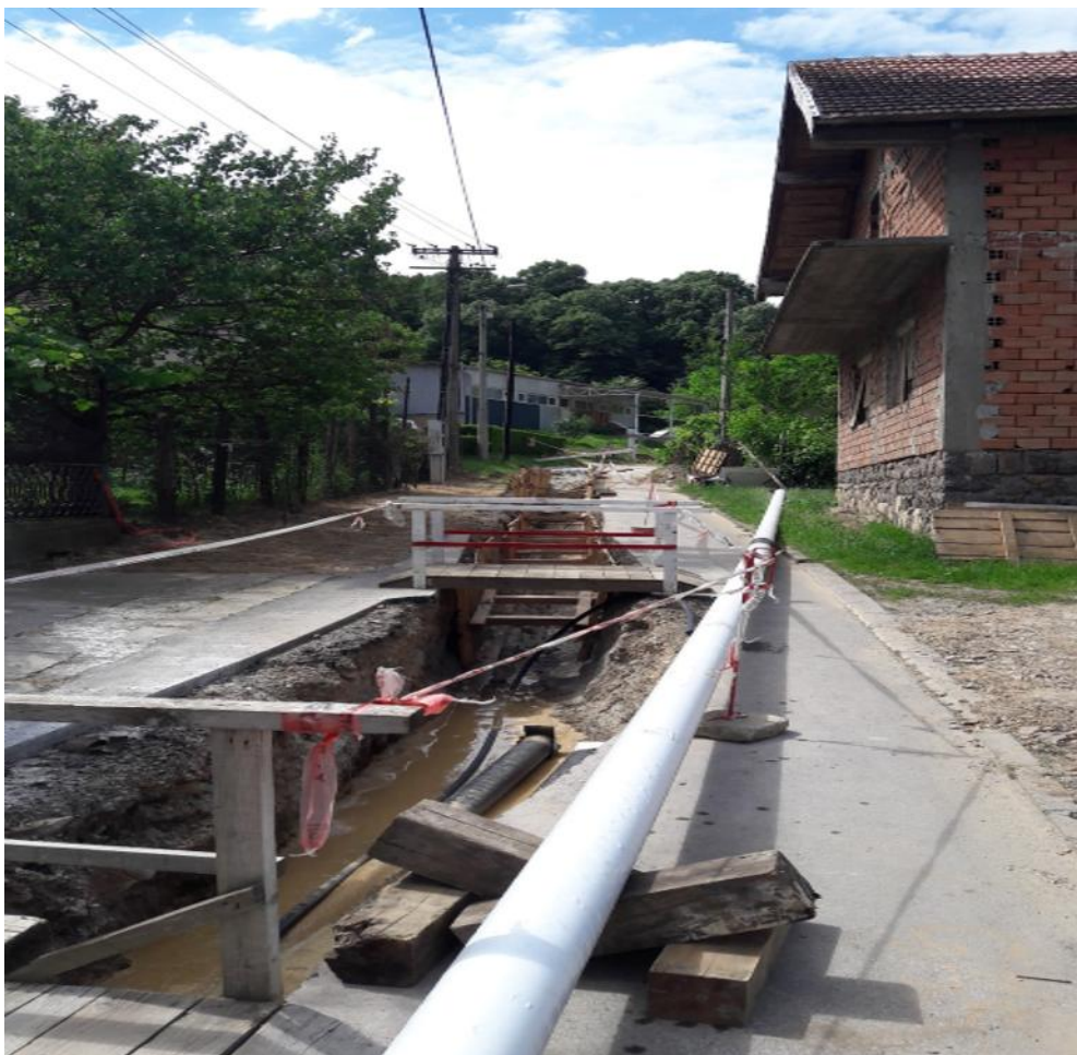
Postavljanje novih predizolovanih čeličnih cevovoda – kroz naseljeno mesto.
