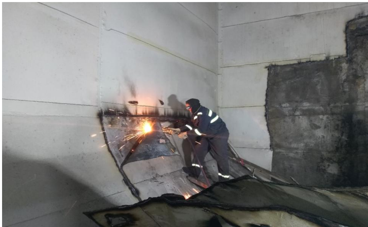
Unutrašnjost rezervoara od 12.000 m 3 za skladištenje euro dizela – radovi skidanja starog čeličnog lima.
