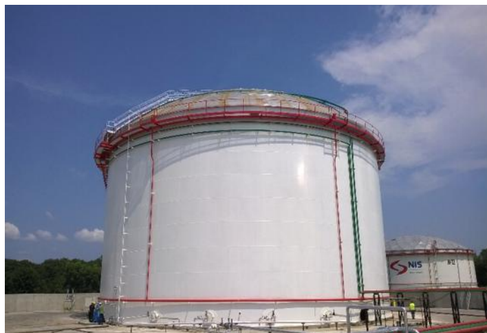
Rezervoar od 20.000 m 3 za skladištenje sirove nafte.
