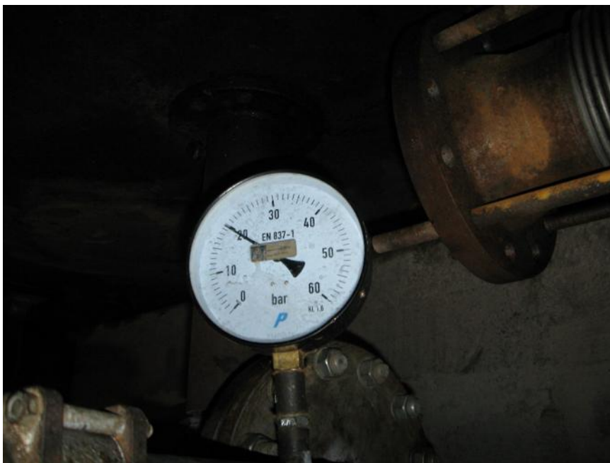
Praćenje postepenog podizanja pritiska ukopanog čeličnog cevovoda.
