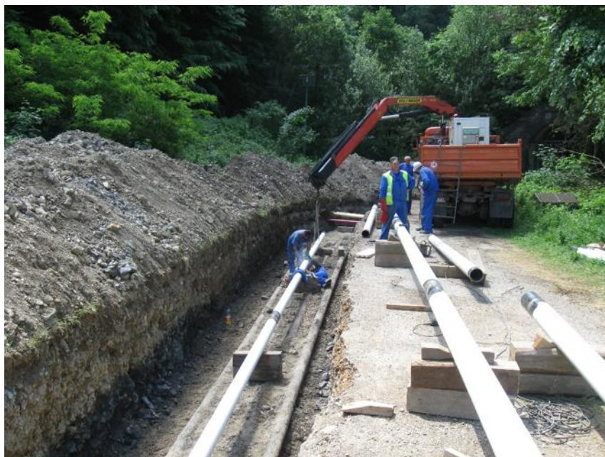
Postavljanje novih predizolovanih čeličnih cevovoda.
