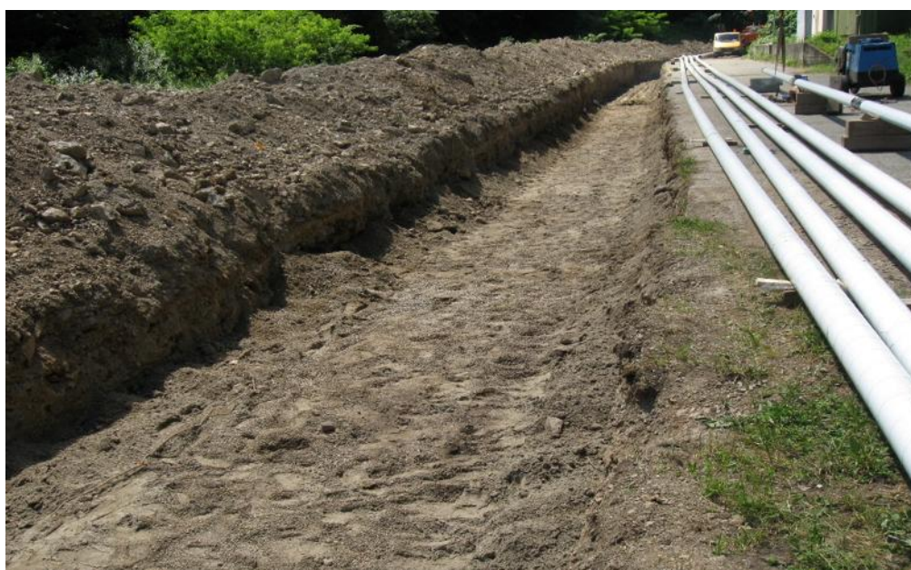
Postavljanje novih predizolovanih čeličnih cevovoda – izolovanje mesta zavaravivanja.
