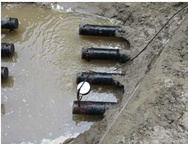
Ispitivanje hermetičnosti ukopanog čeličnog cevovodu na 55 bar.
