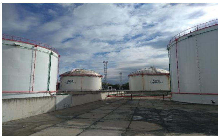
Rezervoari za skladištenje sirove nafte u betonskim tankvanama.
