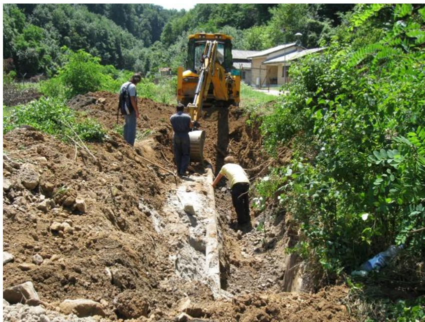
Pronalaženje lokacije mesta perforacije ukopanog čeličnog cevovoda potiskivanjem vode sa komprimovanim pritiskom vazduha.
