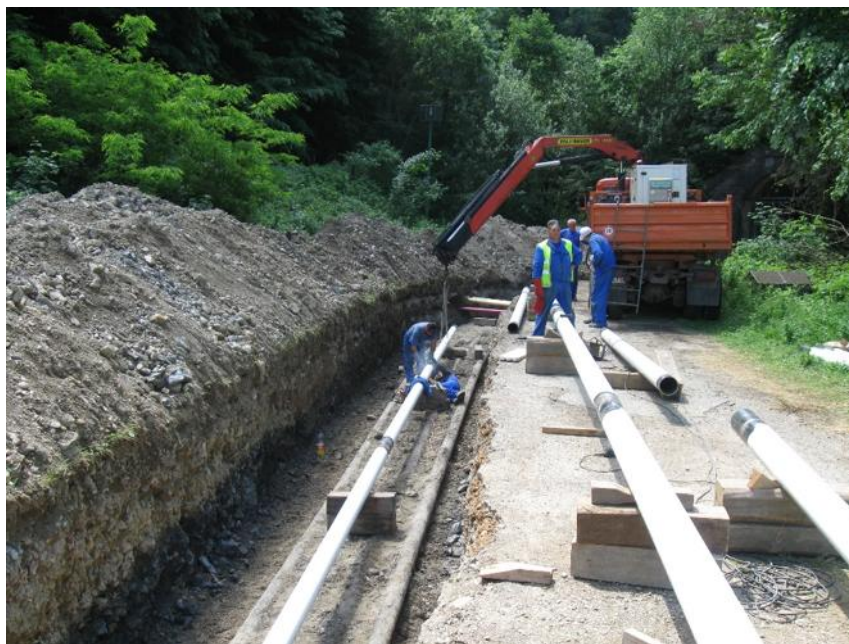
Postavljanje novih predizolovanih čeličnih cevovoda.
