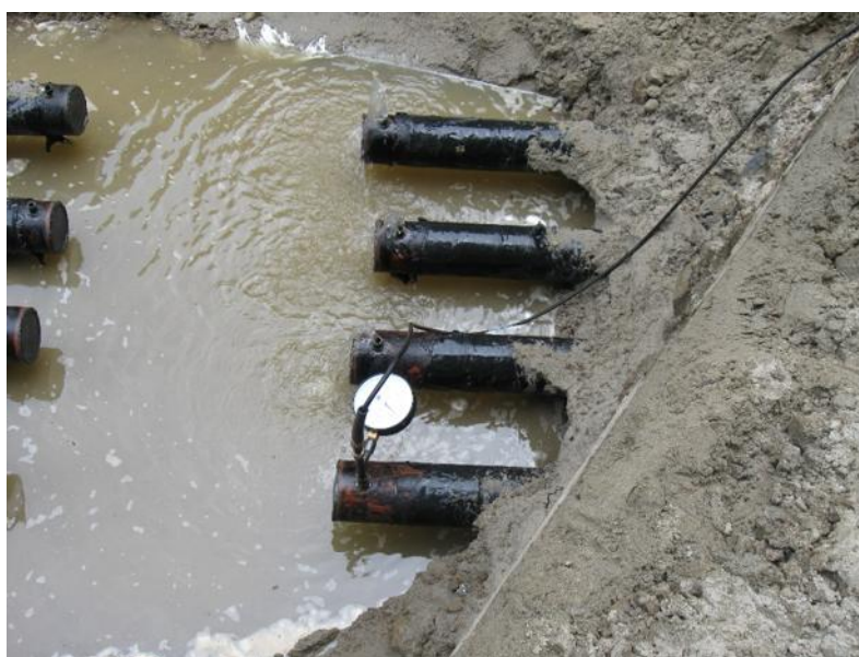
Ispitivanje hermetičnosti ukopanog čeličnog cevovodu na 55 bar.
